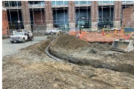
Conduit installation on S. Charles St.
