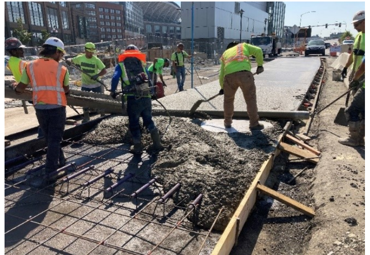
8/31/22: A concrete roadway pour on Alaskan Way South.
