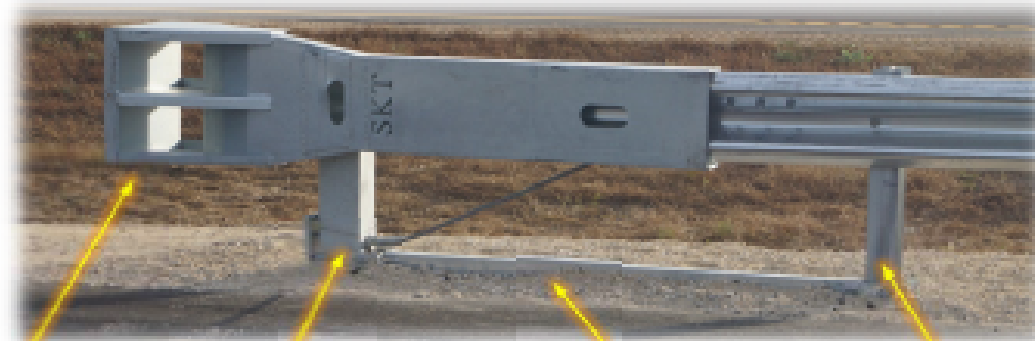
MSKT Impact Head MSKT Upper & Lower Post 1 MSKT Ground Strut MSKT Upper & Lower Post 2
