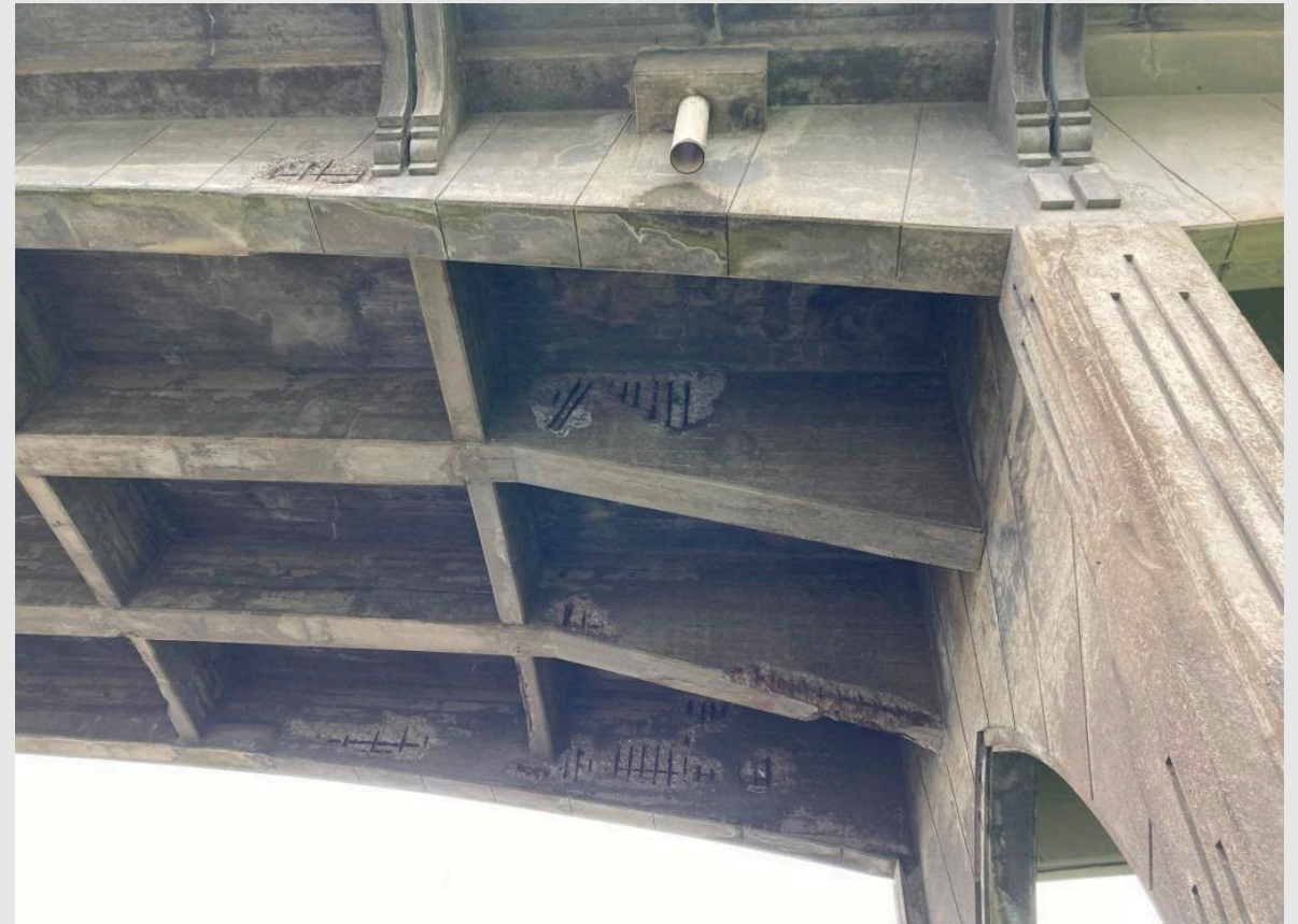
YAQUINA BAY (N. APPROACH) - BR# 01820A - HWY 9 - MP: 141.40
