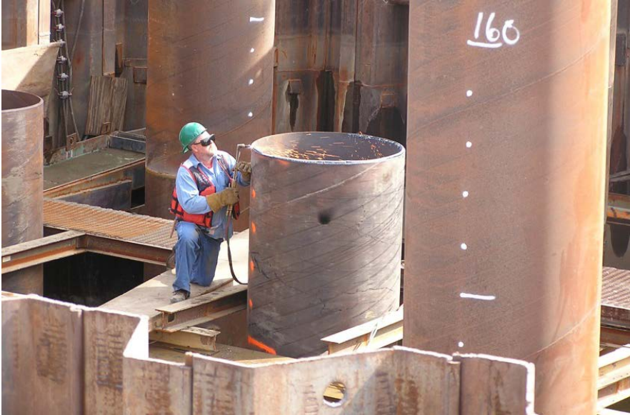
48"φ Pipe Piles
