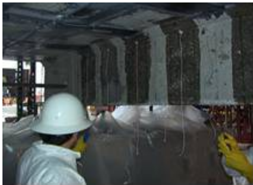
Application of primer coat
