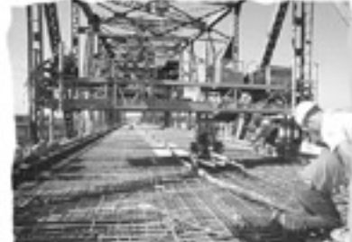
Preparing for a deck pour on the center span
