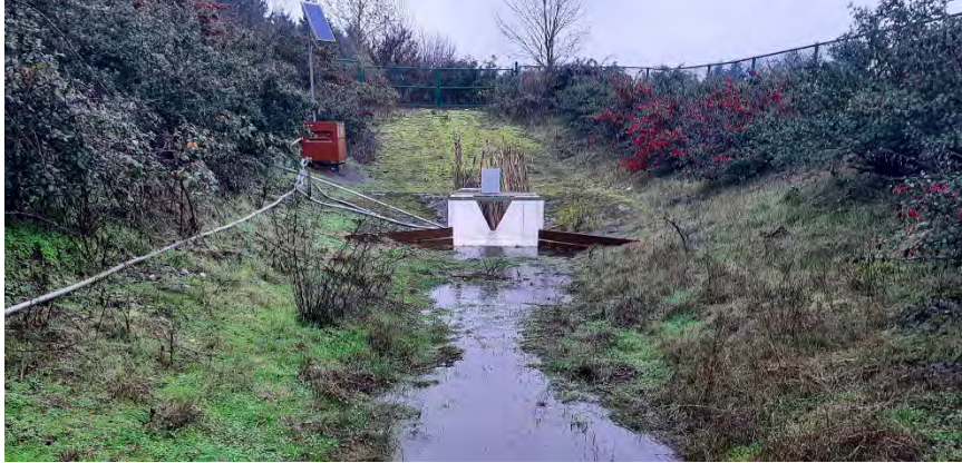
Figure 3. Vancouver bioswale effluent
